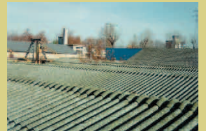
Copertura di capannoni industriali con lastre di cemento-amianto
