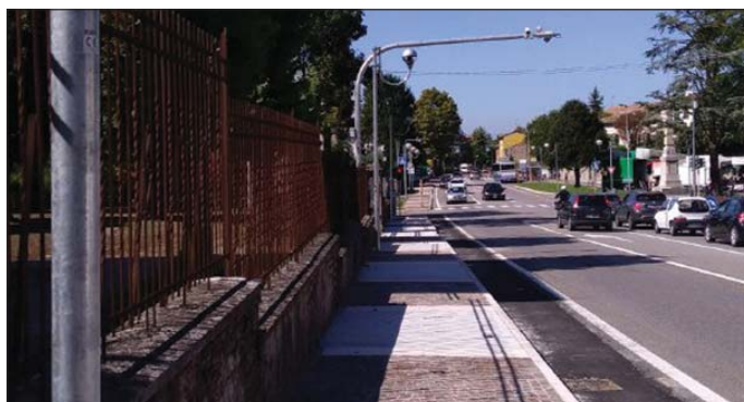
Il nuovo marciapiede realizzato in via Milano completo di punti luce
