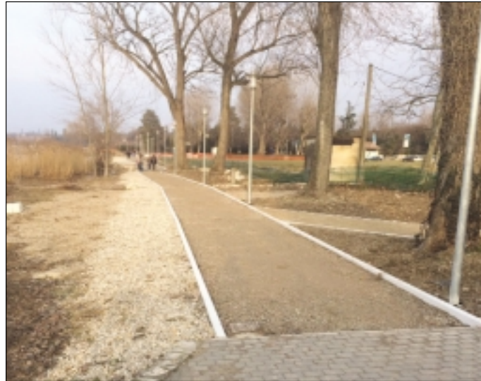
La posa della fibra ottica completata lungo la passeggiata a lago
